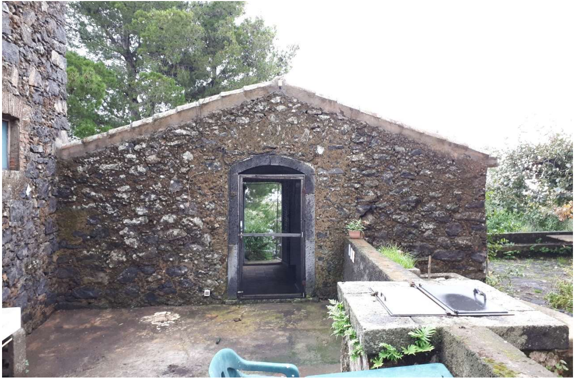
7. dettaglio del cortiletto posteriore e della cisterna interrata
