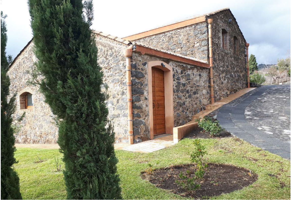
3. Vista del deposito n. 2 da trasformare in villetta
