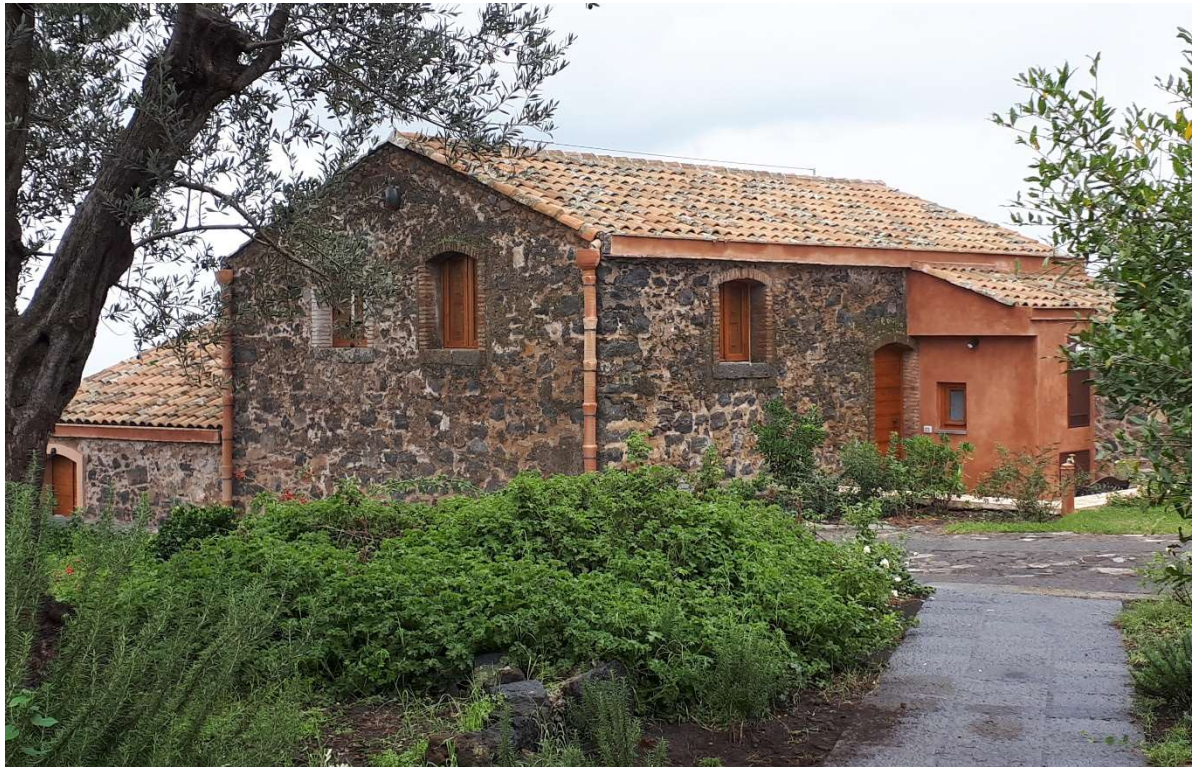
2. Particolare delle tessiture murarie e dei materiali utilizzati
