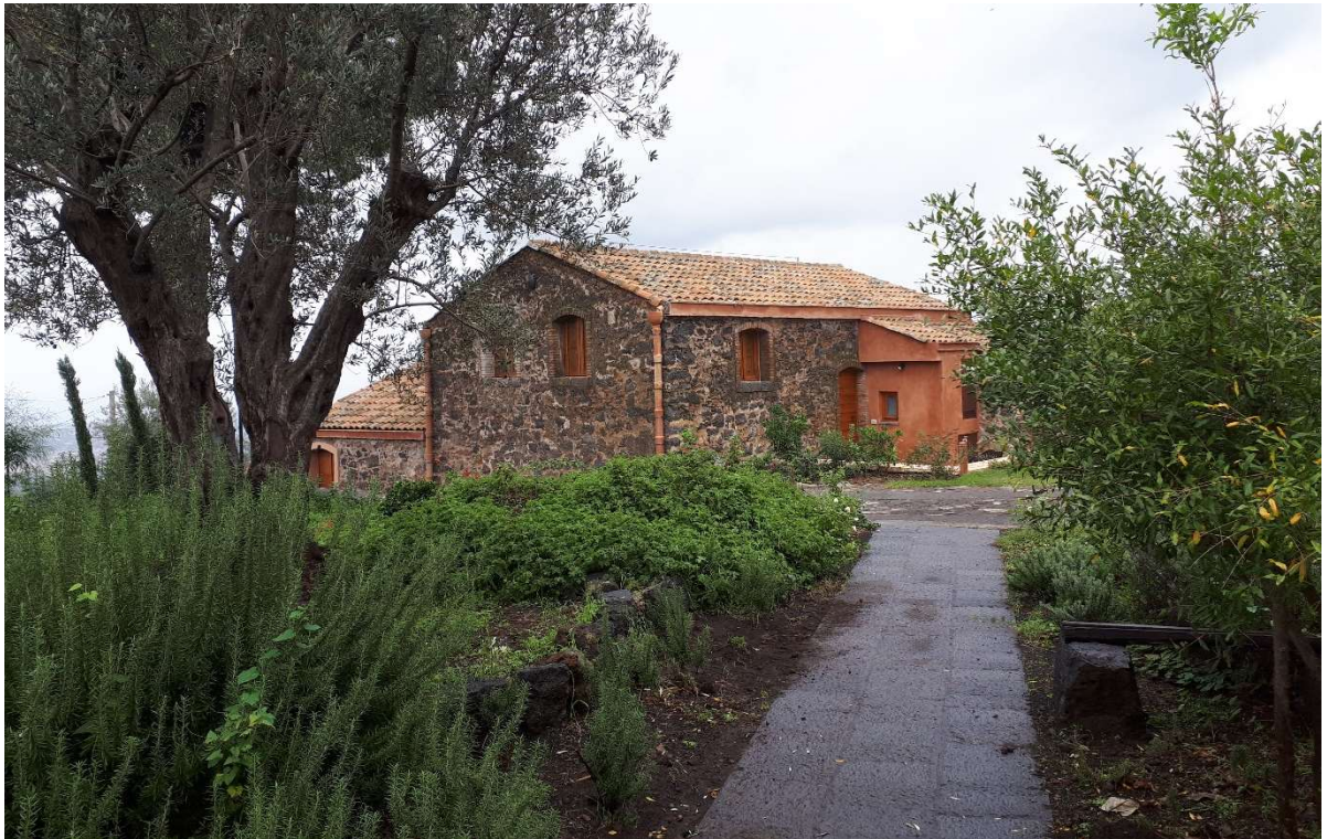
1. Deposito n.2, ristrutturato, da trasformare in villetta
