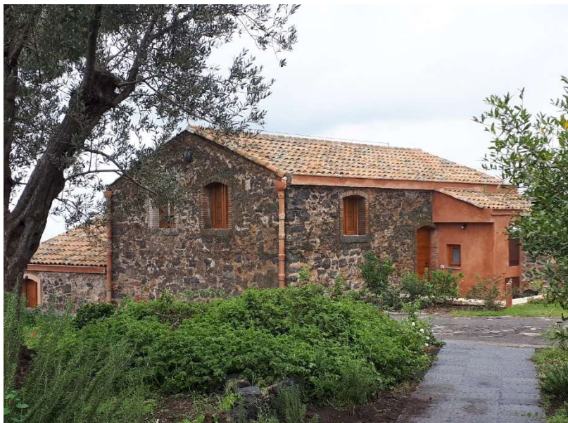
Deposito n.2 già restaurato
