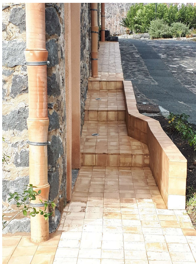
Dettaglio dei pluviali e del marciapiede
